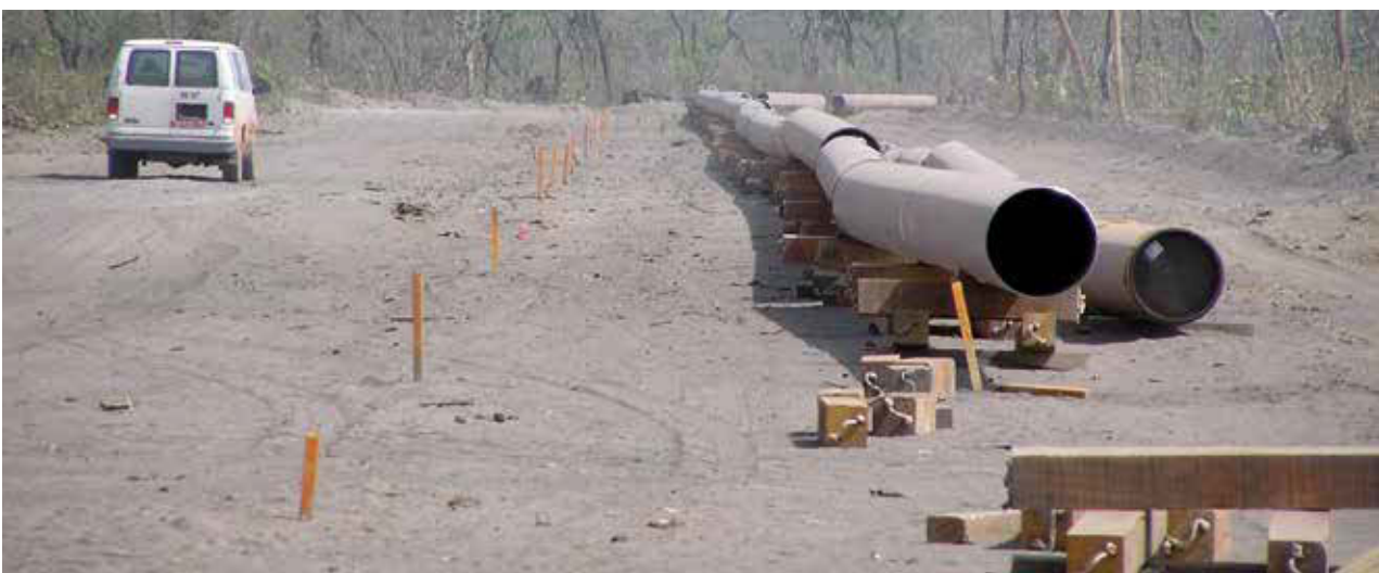
Bau einer Pipeline im Erdölgebiet Doba-Becken im Tschad
