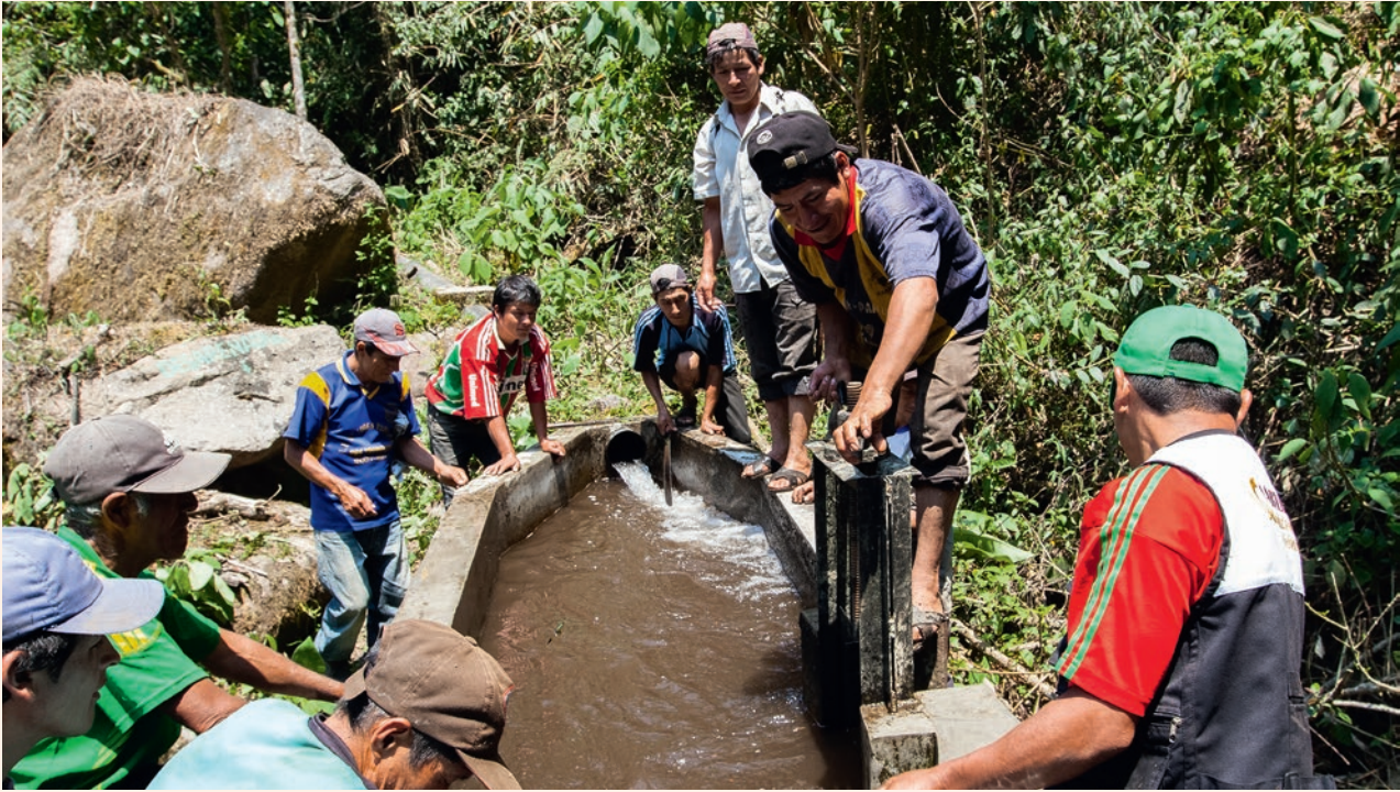
Gemeinsam befreien die Mitglieder des Bewässerungskomitees das Wasserbecken von Schmutz und Laub.
