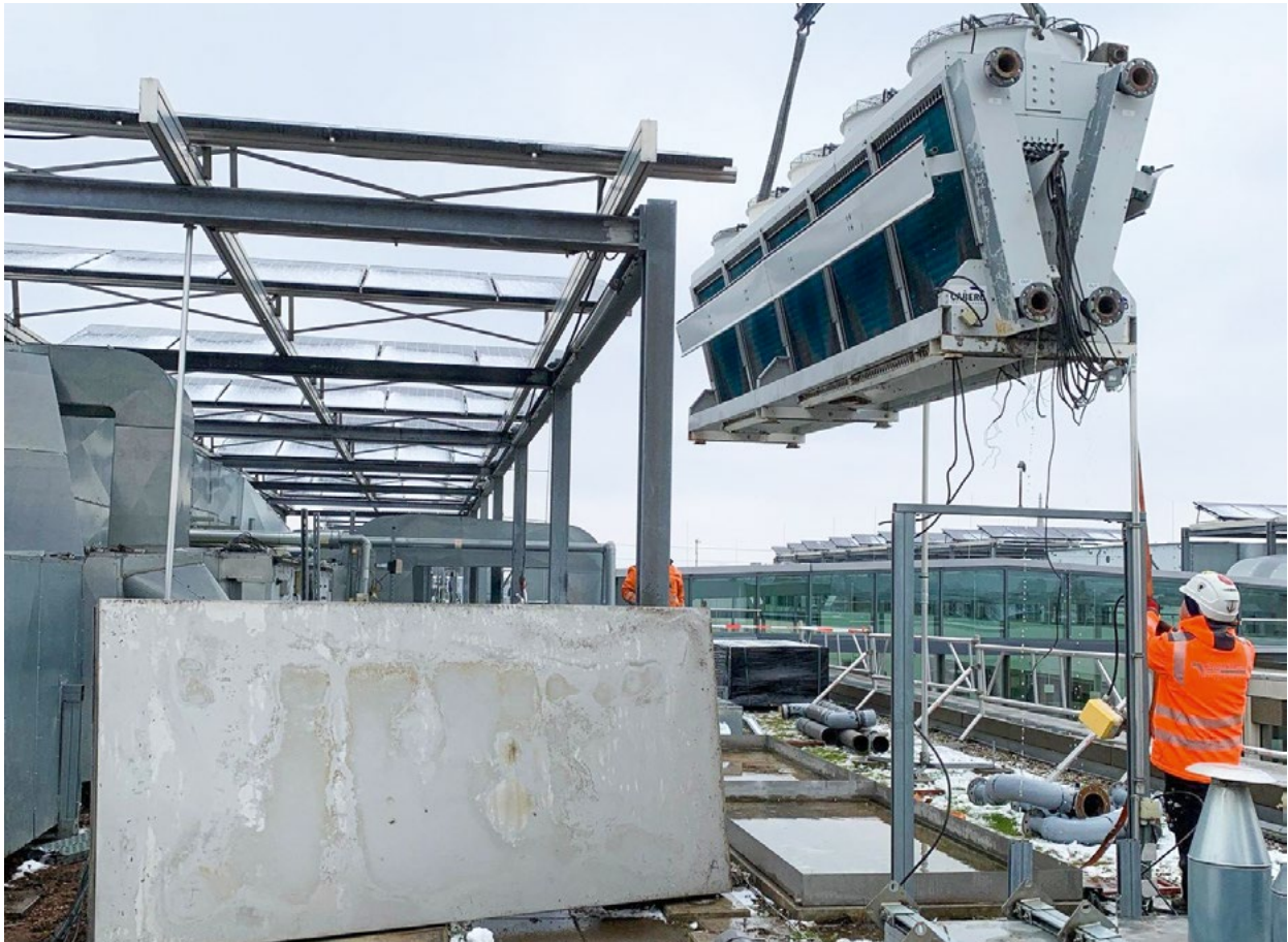
Austausch und Modernisierung der Kühlwerke auf dem EWDE Gebäudedach im März 2023.
