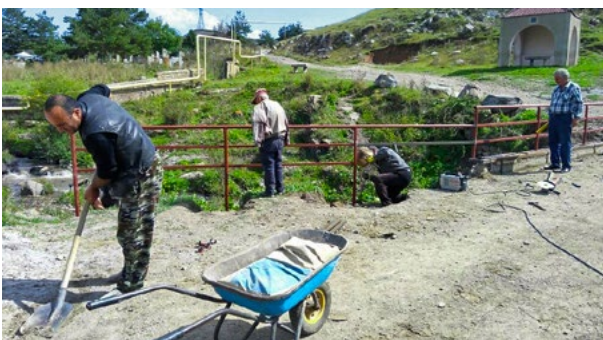
Die Dorfgemeinschaft von Abchalkalaki setzt eine Brücke instand.
